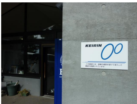
(建物入口の補助標識)
